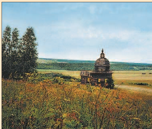
От заброшенного селения осталась полуразрушенная церковь
